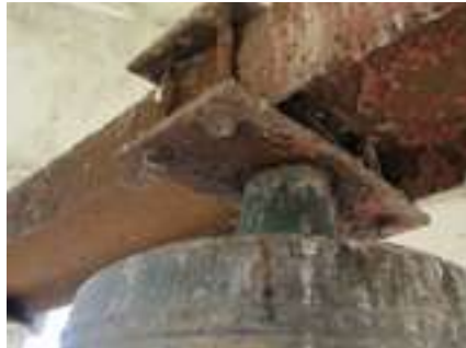
Detalle de sujeción. Campana núm. 1. Palacio Consistorial
